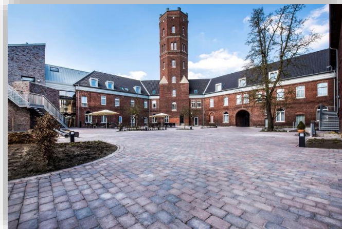
Hotel am Wasserturm © Alexianer Münster GmbH
